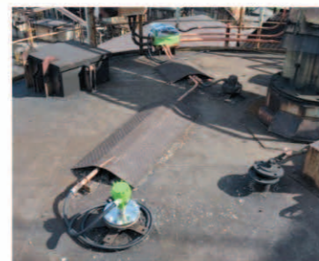
コークホッパー上限用 アドミタンス式 レベルスイッチ
